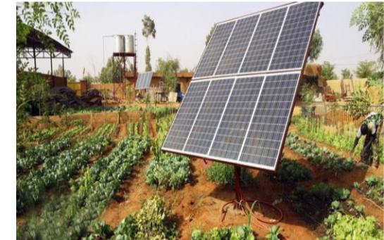
La energia solar es una tecnologia apropiada para el bombeo de agua en lugares distantes, ya que se requiere de un menor y mas sencillo mantenimiento que los molinos de viento, diseñada acorde con los requerimientos del cliente se pueden extraer del subsuelo la cantidad de metros cubicos requeridos.
